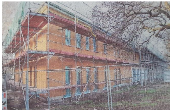
Spätestens im Januar soll das Gerüst am ehemaligen HADIS-Haus fallen
