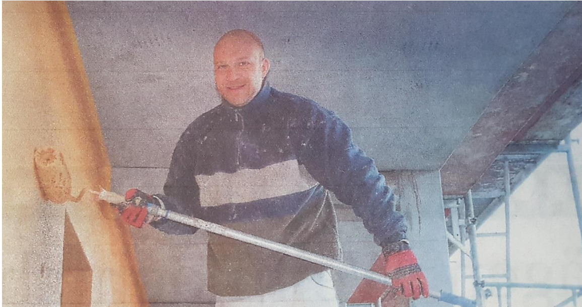
Nach diesem Anstrich wollen Dennis Wende und seine Kollegen von der Fassadenbaufirma noch einen zweiten auftragen, bevor die Temperaturen unter Null Grad Celsius sinken.
